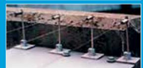
5. Endet die eine Seite des Drahtes an einer senkrecht verlaufenden Mauer, verwenden Sie statt eines Drahtstiftes einen Splint, der mit Spreizdübel in der Mauer befestigt wird.
