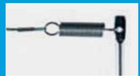
4. Befestigen Sie die Zugfedern bei mehreren Drahtreihen nicht alle auf derselben Seite, sondern abwechselnd. Damit hindern Sie die Tauben daran, unter Nutzung der Federn auf dem System zu landen.
